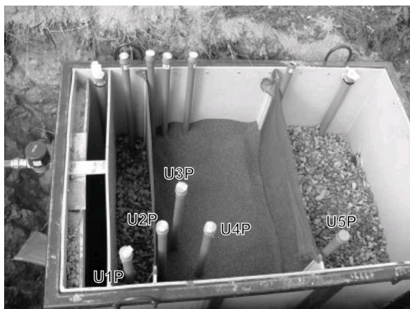
Obr. 1. Konstrukce poloprovodního zařízení (boxu); vlevo nátok vstupní vody přes prepádovou lištu; uprostřed 60 cm široká zóna s Fe-granulátem a systémem 2 × 3 odběrových a měřících míst; vpravo odtok přečištěné vody do drenážní rýhy
