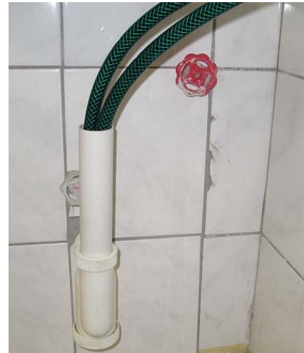
Obr. 7 Zaústění hadic do odpadního sifonu
