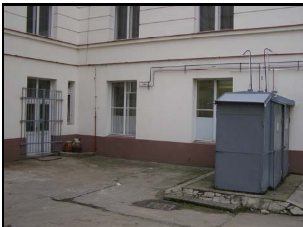
Stav 4. dvora v místě budoucího vstupu do rekonstruovaných laboratoří - 2/2007.
