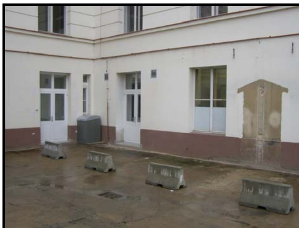
Vstupy do laboratoří S42c, S44, S44a ze 4.dvora po rekonstrukci – 1/2008. Mezi vstupy je umístěn box s filtry tryskacího zařízení. Oprava fasády i dlažby a zastřešení vstupů je plánováno na rok 2008 z prostředků správy budov VŠCHT Praha
