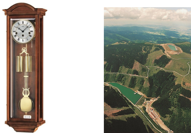
Obrázek 1: Vlevo: Historické hodiny zvané pendlovky využívají závaží k uchování mechanické energie. Vpravo: Vodní nádrž přečerpávací elektrárny Dlouhé stráně slouží jako akumulátor mechanické energie.
